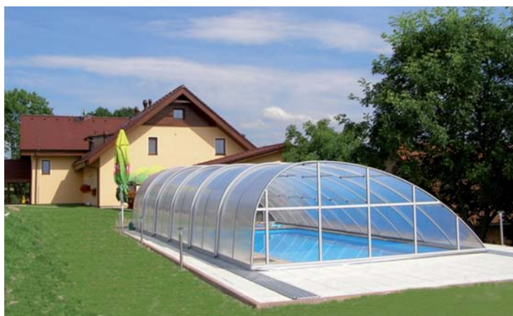
Penzion Pod rozhlednou, Vrbice
